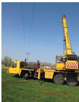
Kontakt žeriava s 22 kV vedením
