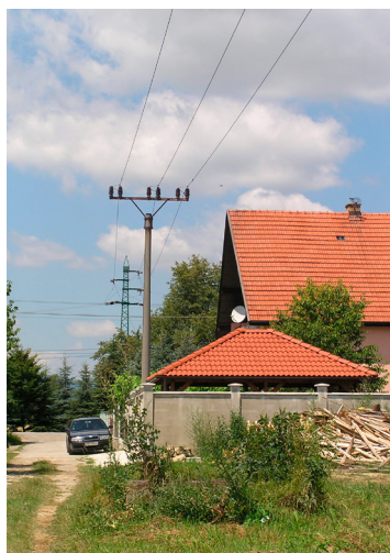
Nepovolená stavba pod vedením
