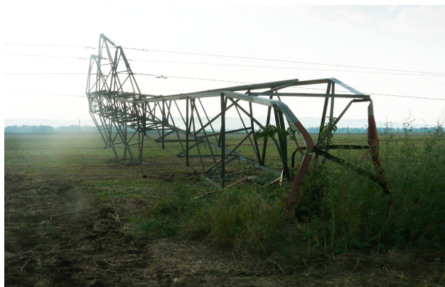
Strhnuté VVN vedenie pri prejazde pod vedeniami a následný pád stožiara (vodič nechal vysunutú betónpumpu a vysokou rýchlosťou strhol telefónne, VN aj VVN vedenie pri Trnave v r. 2018)
